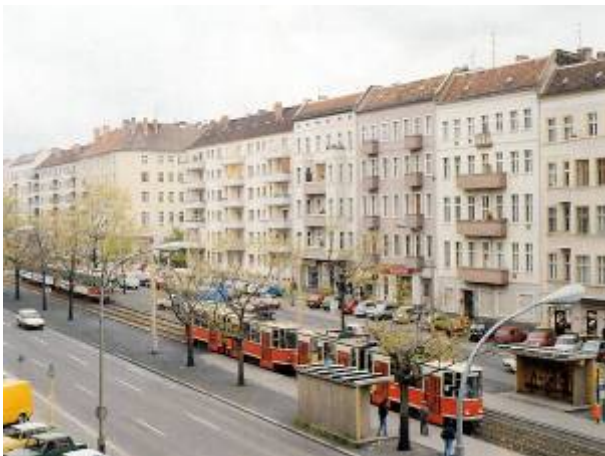
1986: Von BRF sanierte Warschauer Straße in Berlin
