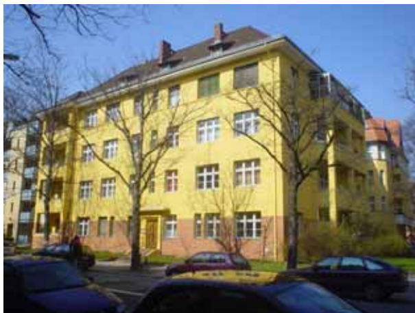
Renovierte Fassade in Berlin-Friedenau
